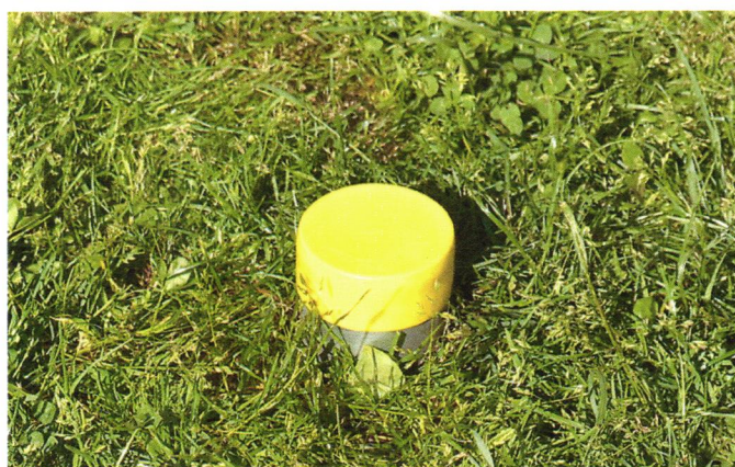
Obr. 2: Kryt zemnej kotvy
